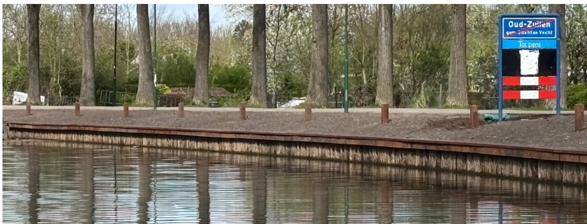
Perkoenpalen-beschoeiing langs Zandpad Oud-Zuilen; het dijkprofiel bleef behouden (2026)
