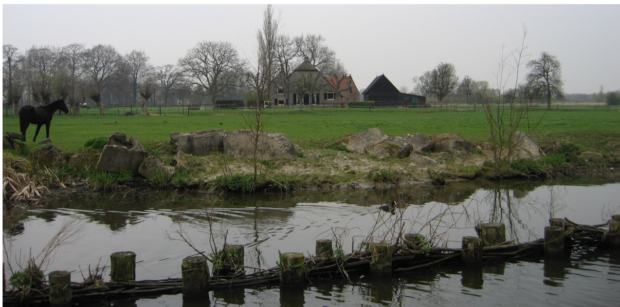
Oever 't Slijk versterkt met betonpalen (ca. 1955) en natuurvriendelijke oever (RPV)
